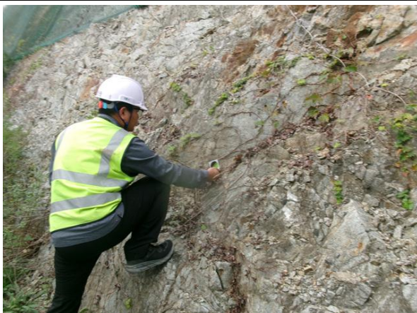
절리면 경사/경사방향 측정
